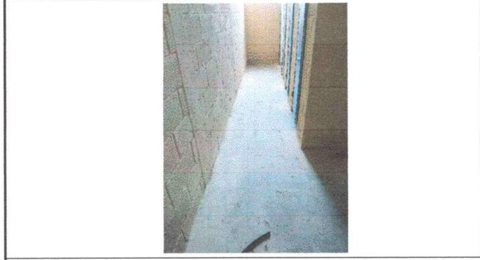
Foto 4: Se observa la necesidad de colocar piso ceramico en modulos 1 y 2
