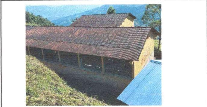
Foto 1: Se observa el deterioro en las cubiertas de lamina modulos 1 y 2
